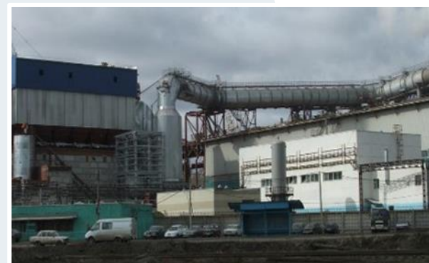
НИЖНЕСЕРГИНСКИЙ МЕТИЗНО-МЕТАЛЛУРГИЧЕСКИЙ ЗАВОД Строительство Березовского электрометаллургического завода
