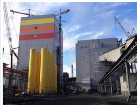
ЕВРАЗ ЗСМК Строительство установки вдувания ПУТ
