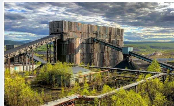
МЕЧЕЛ. ЯКУТУГОЛЬ Капитальный ремонт оборудования и металлоконструкций на обогатительной фабрике «Нерюнгринская»
