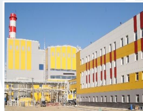
УРЕНГОЙСКАЯ ГРЭС Строительство главного корпуса
