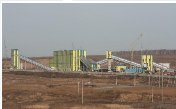
ШАХТОУПРАВЛЕНИЕ «КАРАГАЙЛИНСКОЕ» Строительство обогатительной фабрики кокующих углей мощностью 2,5 млн т/год
