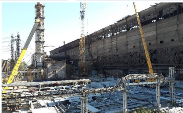
ВМК «КРАСНЫЙ ОКТЯБРЬ» Реконструкция ЭСПЦ -2
