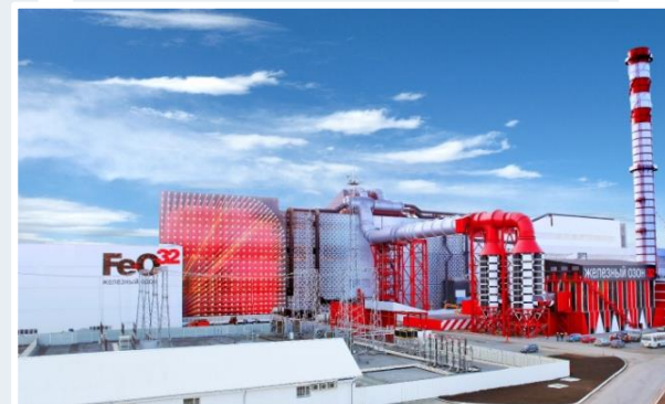
ПЕРВОУРАЛЬСКИЙ НОВОТРУБНЫЙ ЗАВОД Строительство ЭСПЦ
