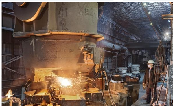
МЕТАЛЛУРГИЧЕСКИЙ ЗАВОД ИМ. А.К. СЕРОВА Строительство главного здания ЭСПЦ
