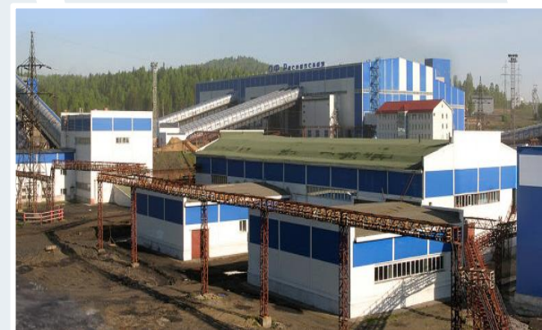
ОБОГАТИТЕЛЬНАЯ ФАБРИКА «РАСПАДСКАЯ» Техническое перевооружение главного корпуса
