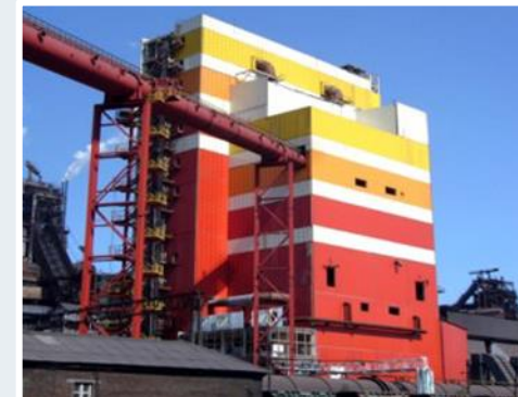
ЕВРАЗ НТМК Строительство установки вдувания ПУТ
