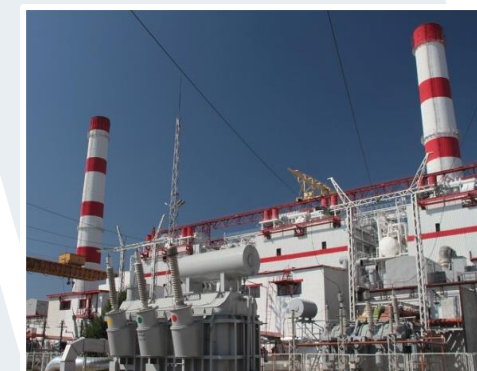
КРАСНОДАРСКАЯ ТЭЦ Расширение ТЭЦ с установкой ПГУ-410
