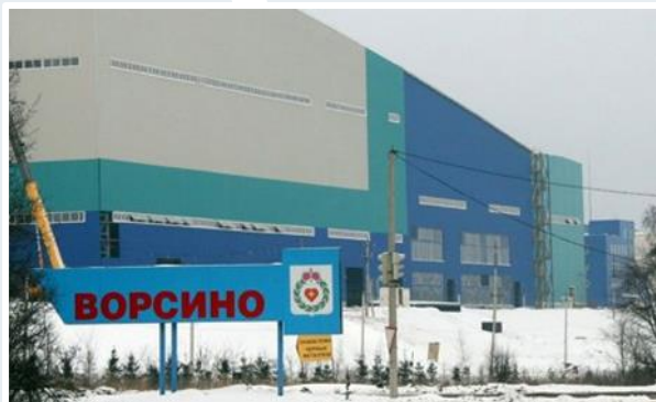
КАЛУЖСКИЙ НАУЧНО-ПРОИЗВОДСТВЕННЫЙ ЭМЗ Строительство ЭСПЦ
