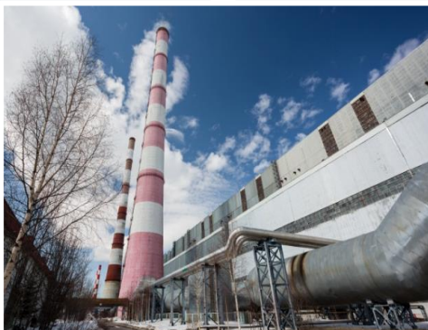
СУРГУТСКАЯ ГРЭС Строительство блока ПГУ- 2х400 МВт
